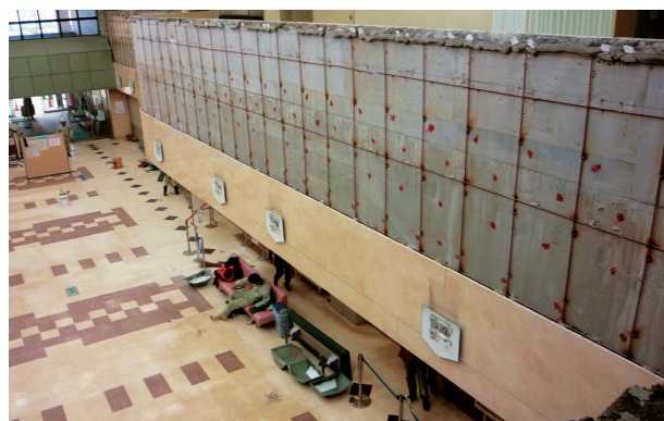
【工事中の外来ホール】
